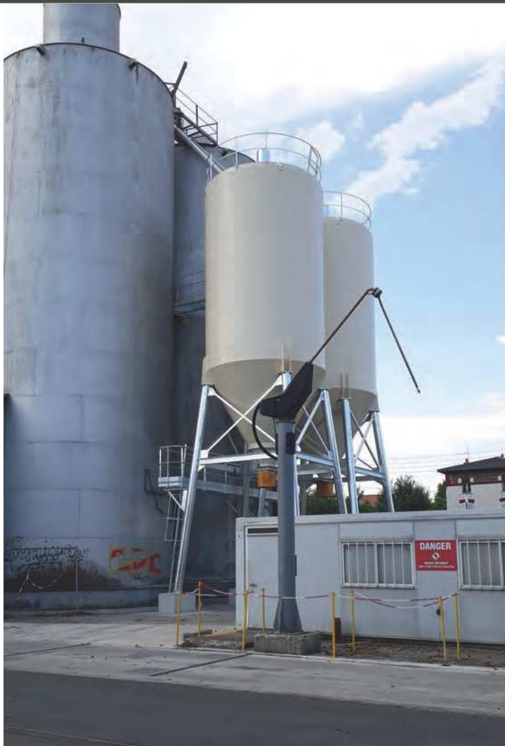
Deux silos de 89 m 3 de 3,82 m de diamètre avec piétement pour le stockage de céréales réalisés et installés en juin 2019 dans le Puy-de-Dôme (63).
